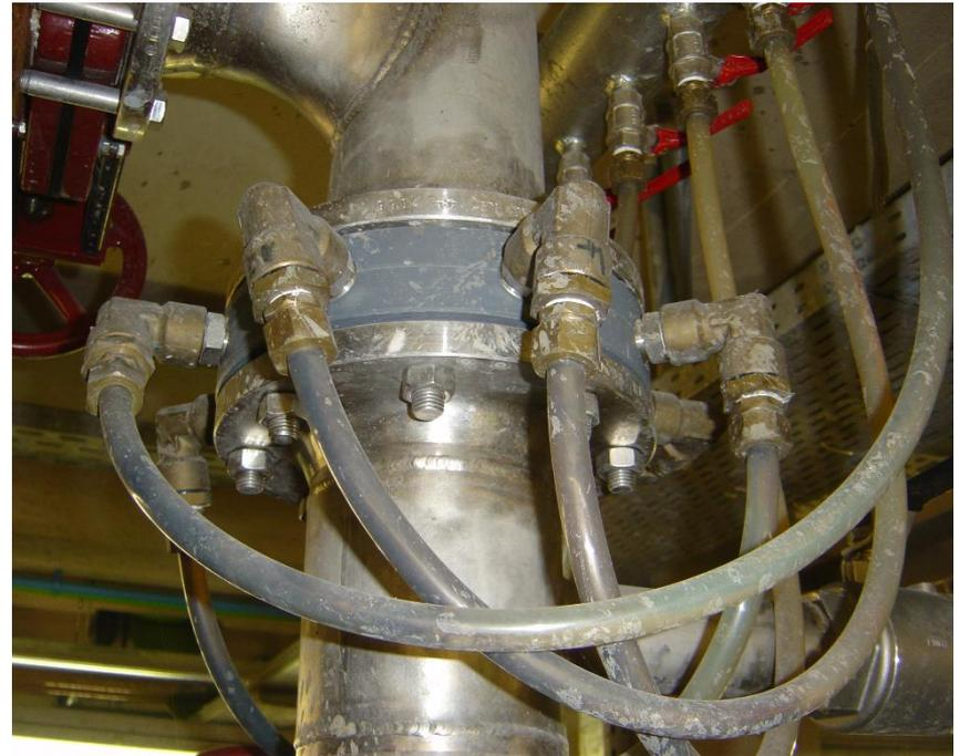
Einspeisung durch einen Ringverteiler
