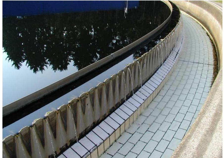
Fest / flüssig Trennung durch Sedimentation in der Nachklärung. Nahezu frei von abfiltr. Stoffen.
