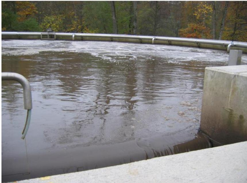
Dosierstelle ins Belebungsbecken mit möglichst hoher Turbulenz
